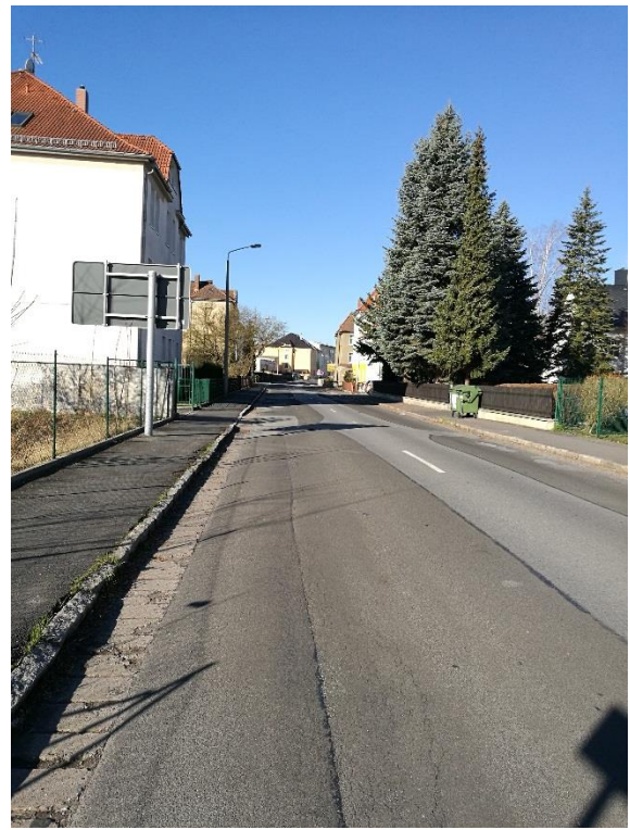
Bauabschnitt 4: Südstraße bis Friedensstraße
