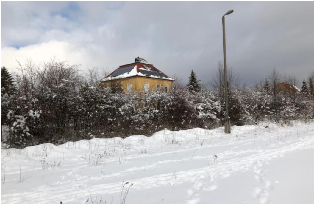
Abbildung 7: Foto Gebäude 2 aus Perspektive PV-Anlage
