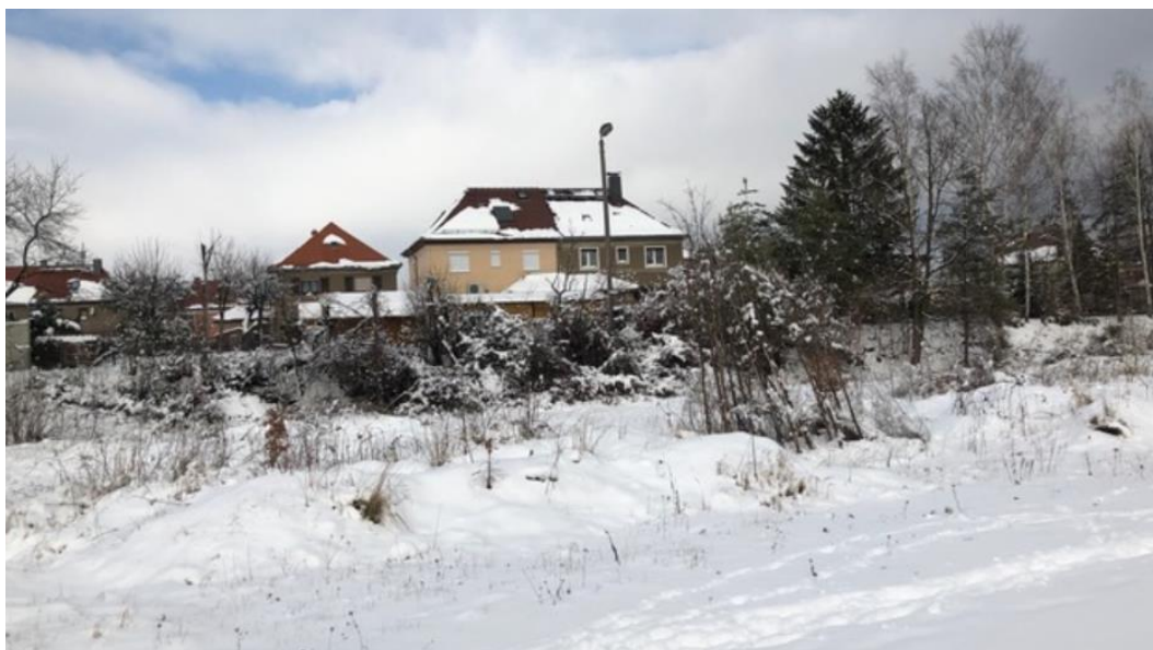
Abbildung 18: Foto Gebäude 5 aus Perspektive PV-Anlage
