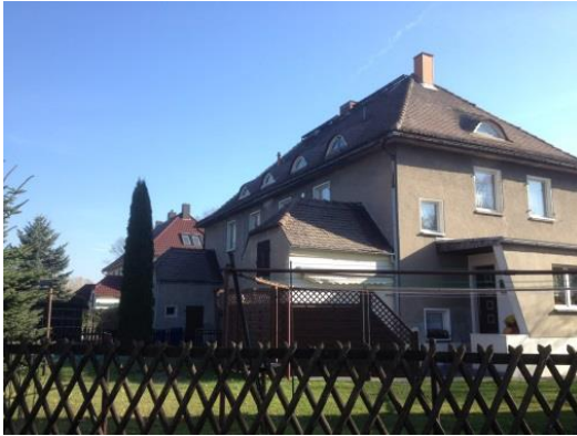
Abb: 12 Wohnbebauung Am Werk
