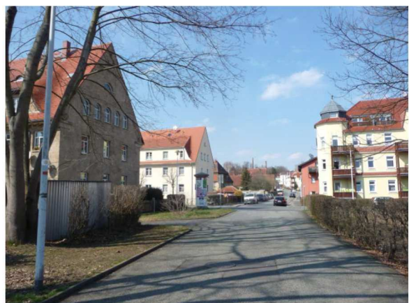
Abb.: 12 Kreuzungsbereich Weststraße aus Richtung Pescheckstraße
