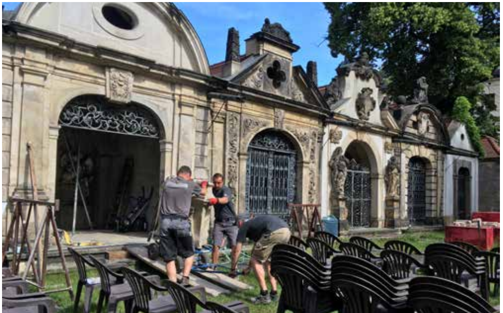
Restaurierungsarbeiten an den Grufthäusern des Klosterfriedhofes in Zittau
