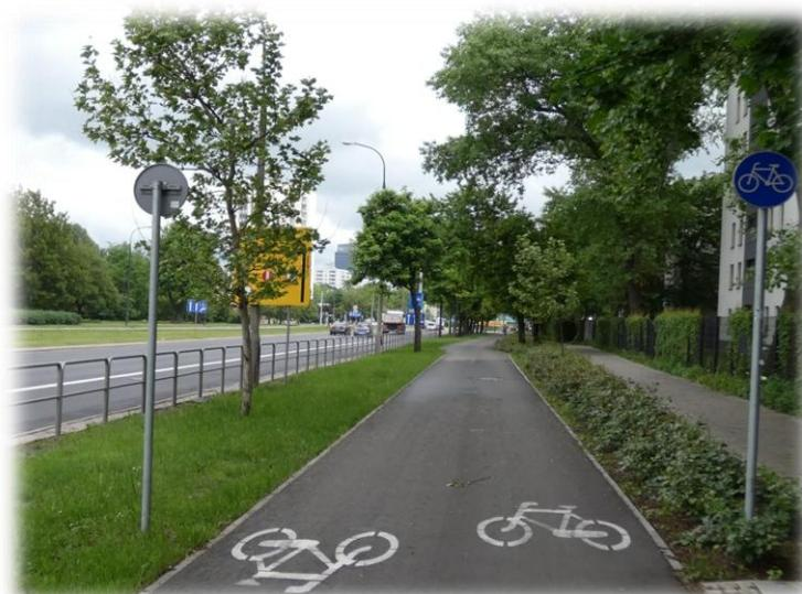
Foto. 1. Wydzielona droga dla rowerów – dwukierunkowa z separacją zielenicem (szerokość 2,5 m, nawierzchnia asfaltowa, oznakowanie pionowe C-13, oznakowanie poziome P-23).
