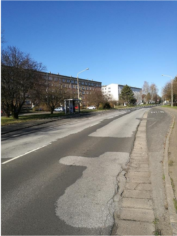
Bauabschnitt 3: Hochwaldstraße bis Südstraße
