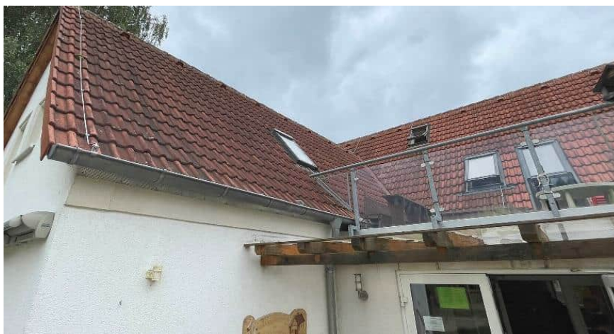
Die Dacheindeckung wurde mit einer Betoneindeckung ausgeführt.
