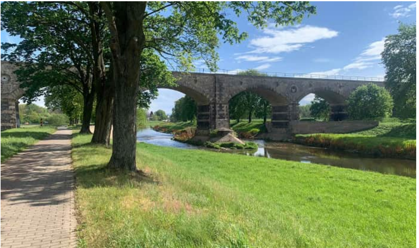
Abb.08 Radweg am Neiße- Viadukt
