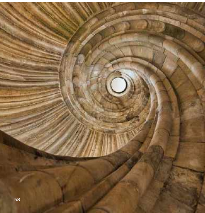
Wendelstein, freistehende Wendeltreppe ©Mark Lämmchen
